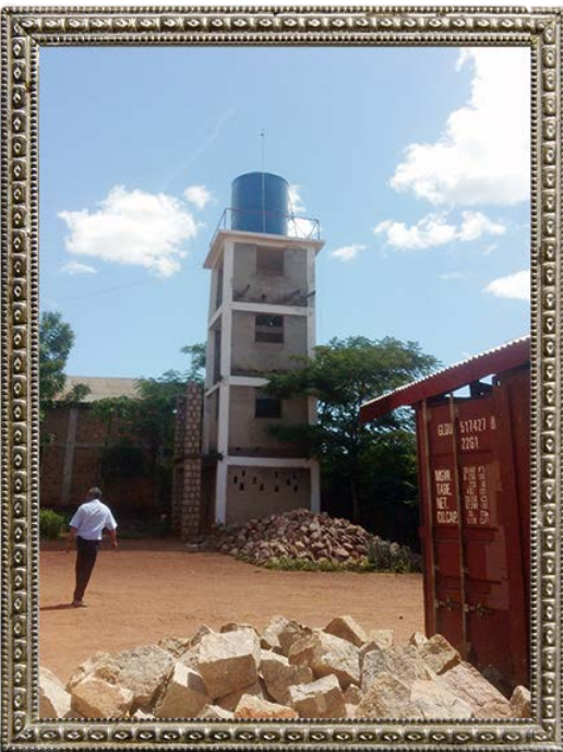
Réservoir d'eau de MORARANO, Emplacement du futur BATSOL MORARANO, juin 2017
